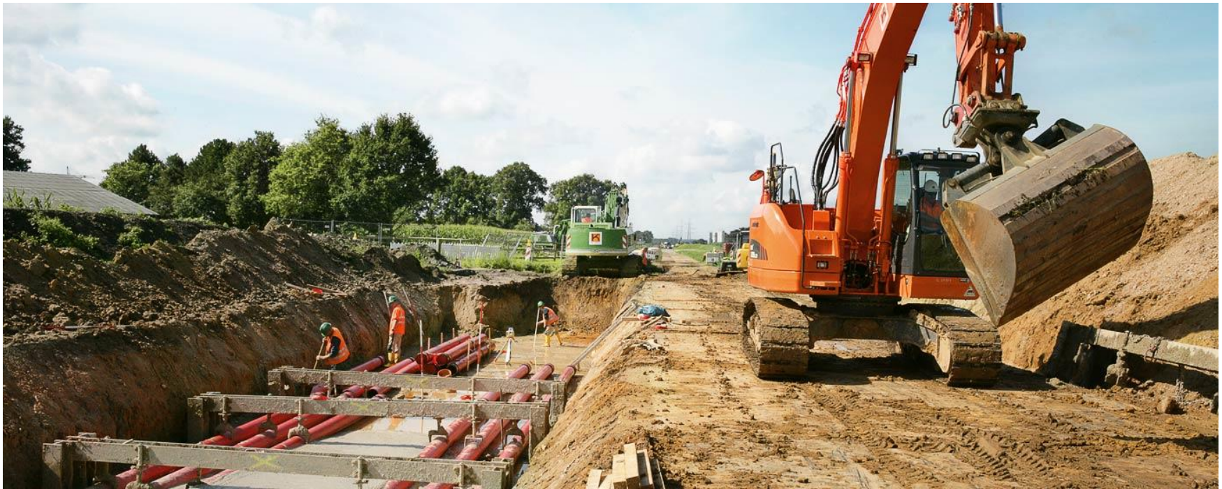
Chantier pour un câblage souterrain à Raesfeld, Allemagne
