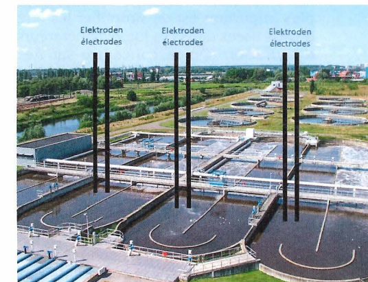
Figure 3 : Bassins biologiques dans lesquels, si les soufflantes d'aération étaient remplacées par des électrodes de piles à combustible microbienne, 70 % d'électricité pourraient être épargnés. (Photo : Scom, HES SO Valais).
