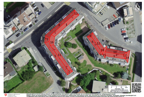
Vogelperspektive der Bedachung, die rot eingefärbten Flächen kommen für die Montage von Photovoltaik-Panels in Frage
